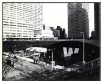
新宿駅西口に設けられた二基のテント
